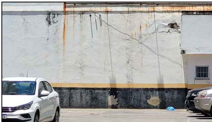
Interior do Imóvel – vista lateral esquerda com fundos dos números 21 e 23 pelo Largo São Francisco de Paula
