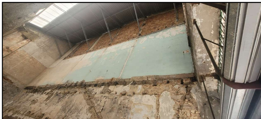
Interior do Imóvel – Paredes Laterais
