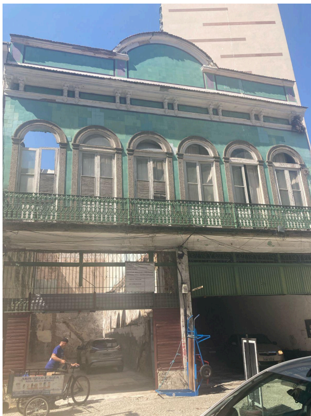
Fig. 16 - Rua do Teatro, 23. Fonte: Requalifica Centro (ano 2025).
