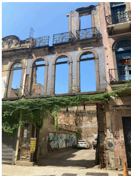
Fig. 14 - Rua do Teatro, 17. Fonte: Requalifica Centro (ano 2025)
