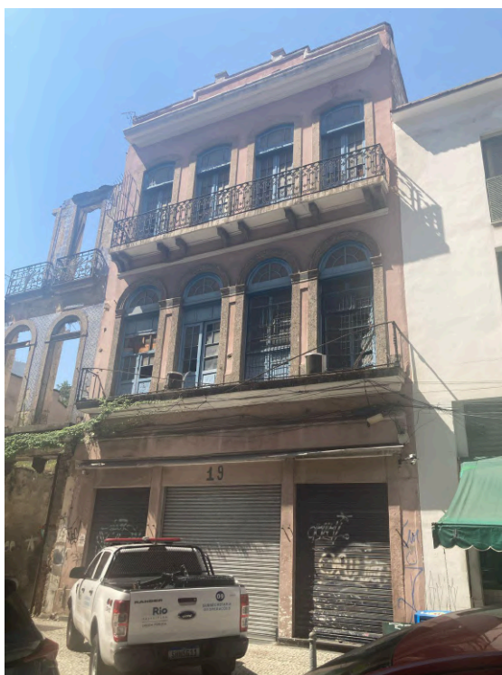
Fig. 15 - Rua do Teatro, 19. Fonte: Requalifica Centro (ano 2025)
