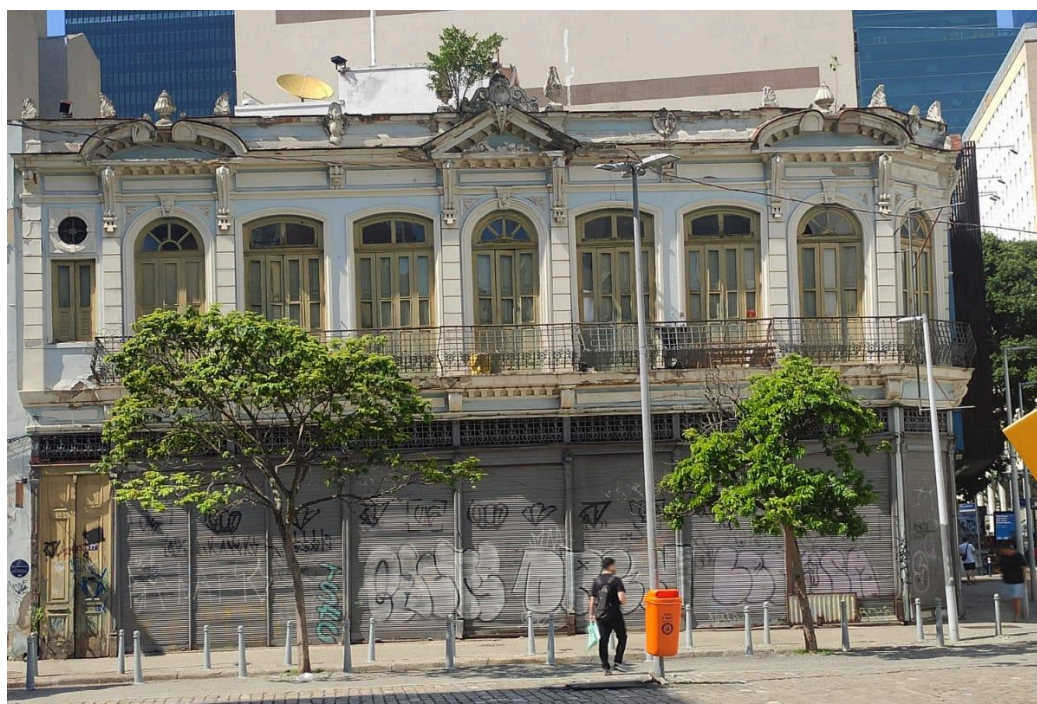
Fig. 20 - Rua do Teatro, 37. Fonte: Requalifica Centro (ano 2025)
