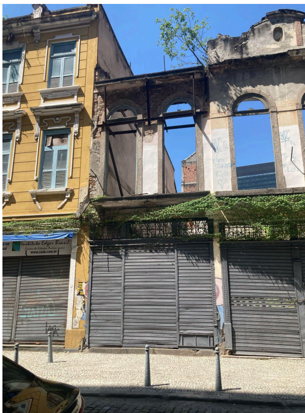
Fig. 12 - Rua do Teatro, 9. Fonte: Requalifica Centro (ano 2025)
